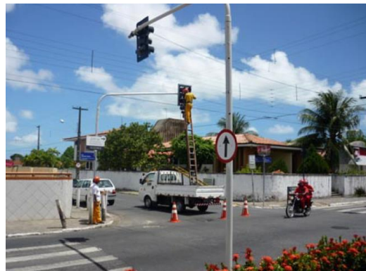
Figura 3 - Implementação de Projeto de Sinalização Semafórica em João Pessoa/PB
